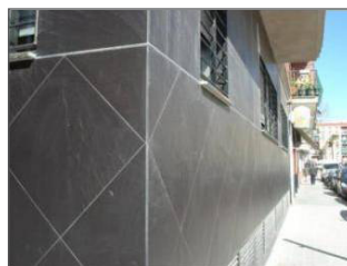
Cambio de orientación del embaldosado.
